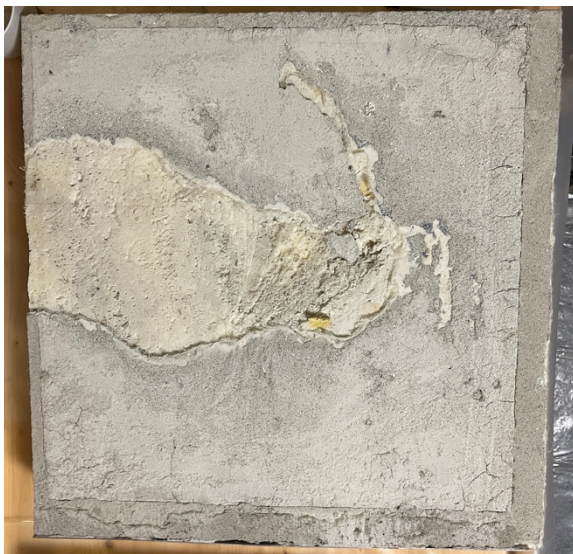
Abb. 7: Rückseite des Bildfeldes P nach der Abnahme. Der Feinputz setzt sich aus zwei separaten Tagewerken für die Rahmung und Füllung zusammen. Foto: E. Fritz, 2023.
