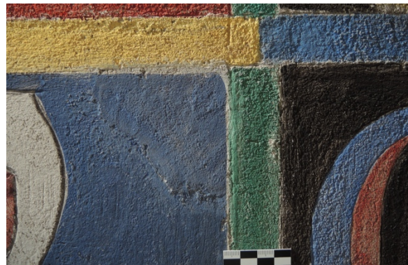
Abb. 20: Putzergänzung beim Bildfeld P. Foto: E. Fritz, 2023.
