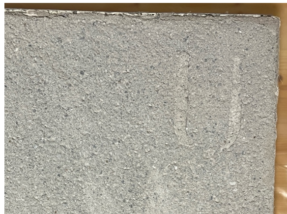
Abb. 5: Rückseite des Bildfeldes U nach der Abnahme. Im Grobputz ist der Buchstabe als Tagewerk sichtbar. Foto: E. Fritz, 2023.
