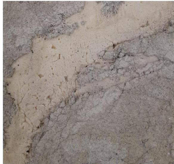
Abb. 6: Zerstörtes dünnes Facing, Bildfeld XY
